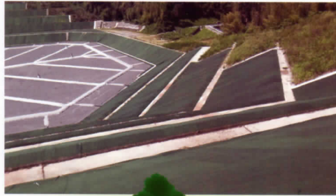
■ 処分場全体の漏水をモニターで検知
