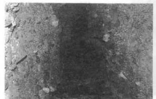
和無田町のマンボ 出口付近の横穴の大きさ 幅60cm 高さ100cm 流量は一秒間に0.0086立米 礫層よりなる。礫の最大径30cm 礫の成分は粘土
