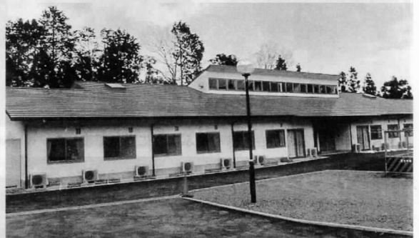
完成したグループホーム
