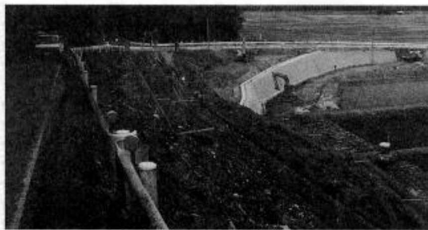
急ピッチの拡幅工事
