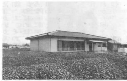
完成した農業構造改善センター
