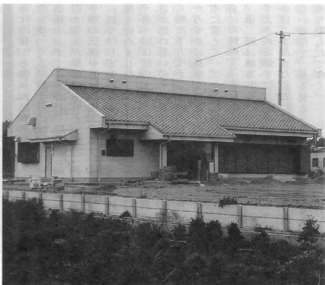
完成した構造改善センター
