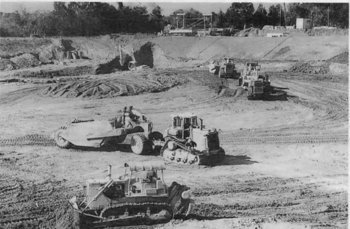
大型重機によって進む造成工事 Bゾーン
