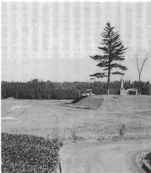
工事が進む農村公園
