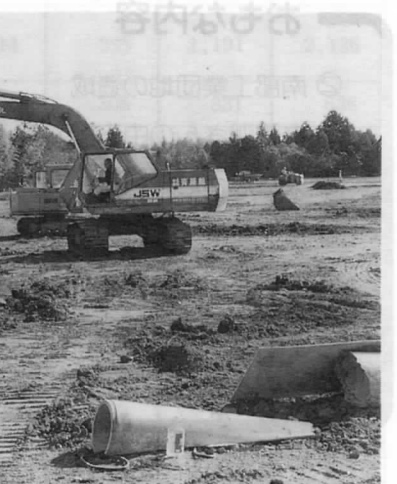
付設工事も同時に進むCゾーン
