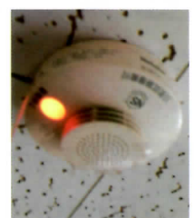
住宅用火災警報器の点検
