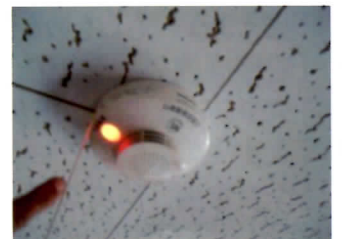
住宅用火災警報器の点検
